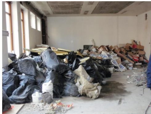
Sortering av avfall ved riving av bygg
